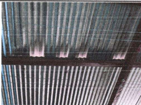
Foto 5: Estructura de madera en mal estado y laminas rotas. Modulo 1
