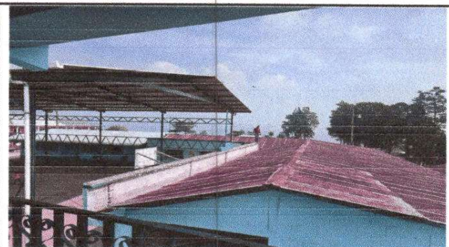
Foto 6: Techo en mal estado, lamina oxidada, quebrada y entra el agua cuando llueve. Modulo 1
